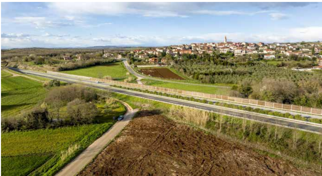
Sl. 89. Zvučni zid uz autocestu u blizini naselja Brtonigle koji bi se mogao unaprijediti sadnjom drvoreda
