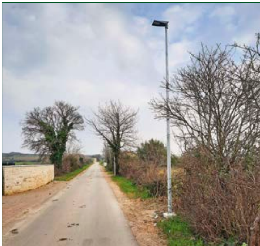
LED cestovna javna rasvjeta na području Općine Brtonigla-Verteneglio
